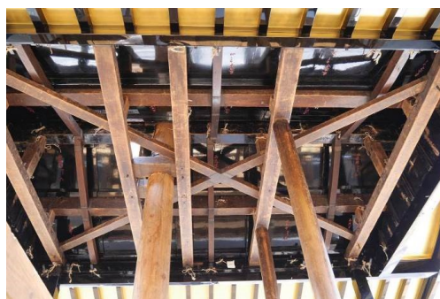
図6 南観音山 観音柱と梁
